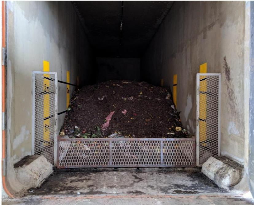
**Figura 6.4.** Substrato em leira no interior dos reatores MESB.
