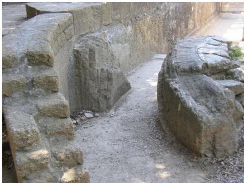
Figura 1.2 – Incrustação em uma seção de um aqueduto romano
