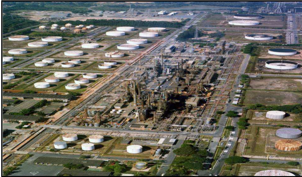
Figura 3.1 – Foto aérea da REGAP (Petrobras, 2009)
