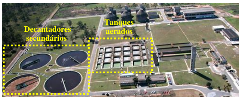
Figura II.1. Vista superior de um LAC inserido na ETE de Suzano (SP) (SABESP, 2013)
