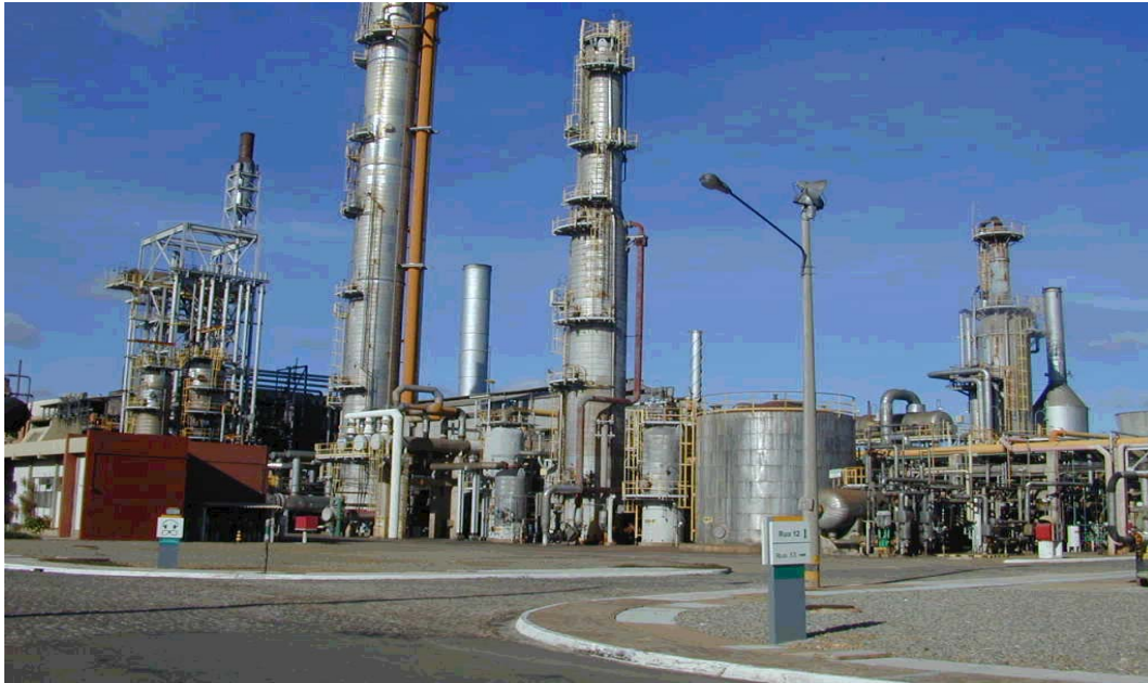
Figura 3.3 Vista Geral da Planta de Amônia da FAFEN em Laranjeiras, SE.
