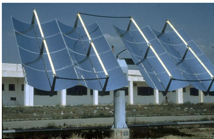
Figura 3.7 Reator PTC instalado na plataforma solar de Almeria (MALATO et al. , 2007).
