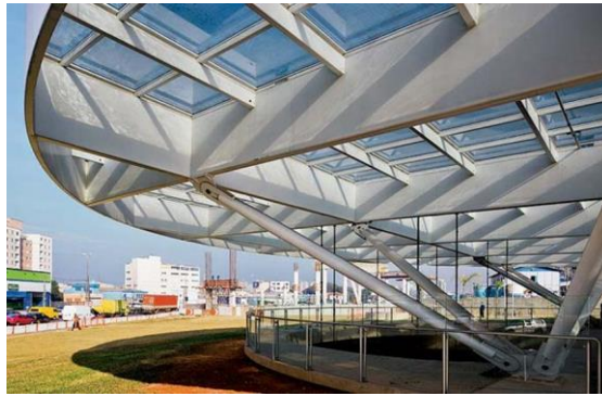
Figura 2.7 – Estação Vila Prudente do metrô, São Paulo. Fonte: http://www.arcoweb.com.br/arquitetura/luiz-esteves-arquitetura-estacao-vila-prudente16-09-2011.html .
